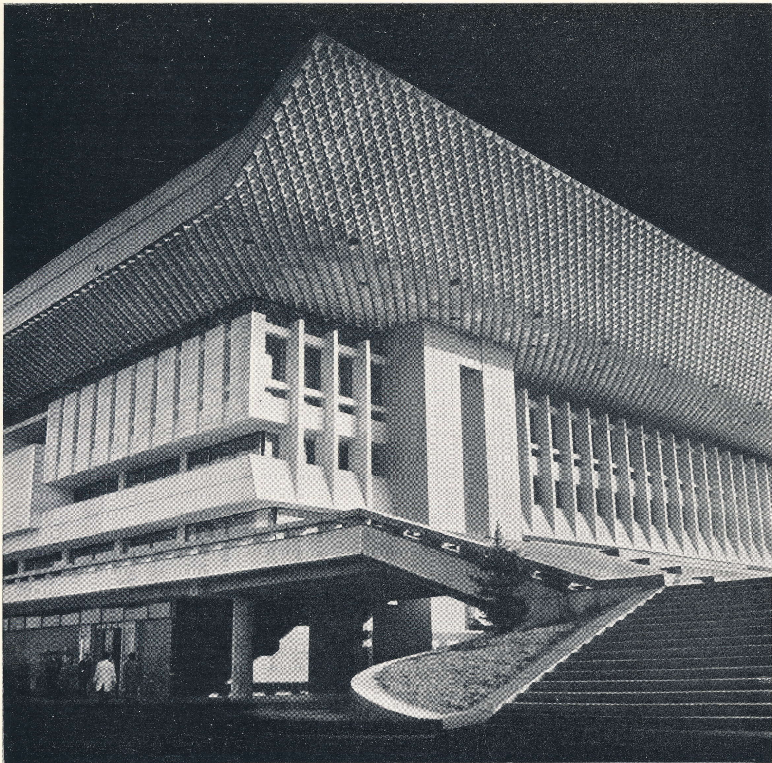
Алма-Ата. Дворец культуры им. В. И. Ленина. Фрагмент. Архитекторы В. Ким, Ю. Ратушный, Н. Рипинский, Л. Ухоботов, инженеры Б. Делов, В. Кукушкин, Н. Кузякин, М. Казыбеков
