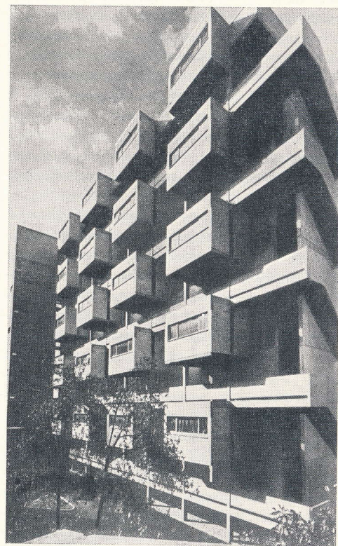
Использование функциональных элементов здания для образования активной пластики; в эркере находится дополнительная комната [Галерейный жилой дом в Сиднее, 1967. Арх. Г. Сейдлер.]
