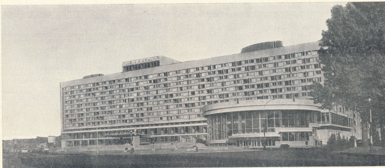
Гостиница «Ленинград». Архитекторы С. Сперанский, Н. Каменский, В. Струzman, при участии инженера Е. Израилева и архитектора В. Волонсевича. Общий вид и интерьер ресторана
