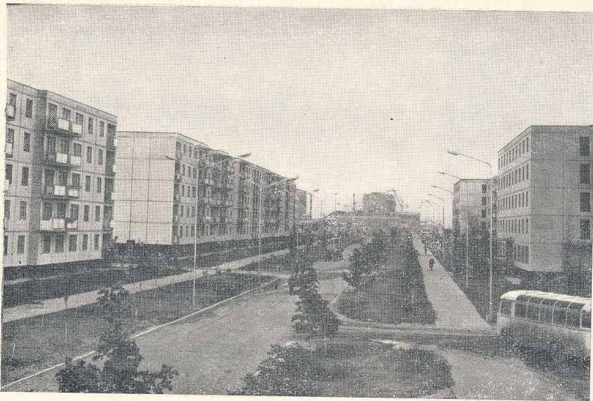
Поселок Энергетиков Запорожской ГРЭС. Слева и справа жилые дома из объемных элементов [Всесоюзный институт «Энерго-жилиндустпроект». Предприятия Приднeповского завода ЖБК]
