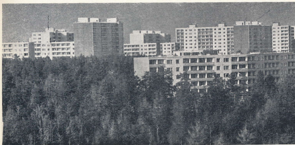
Застройка I микрорайона
