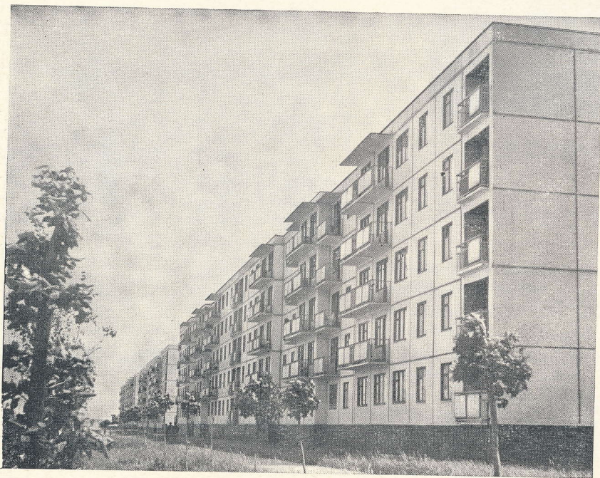
Главный фасад 5-этажных 60- и 90-квартирных жилых домов из унифицированных блок-комнат в жилом поселке Запорожской ГРЭС
