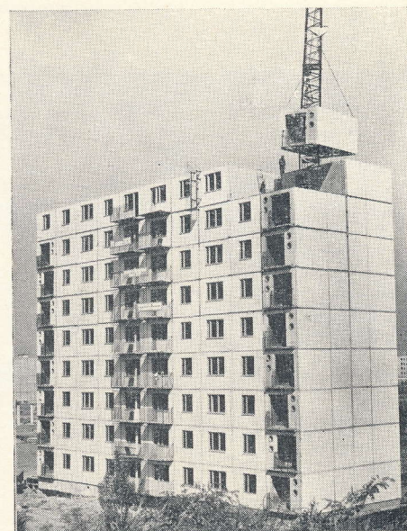
Монтаж блок-комнат 5-го этажа
