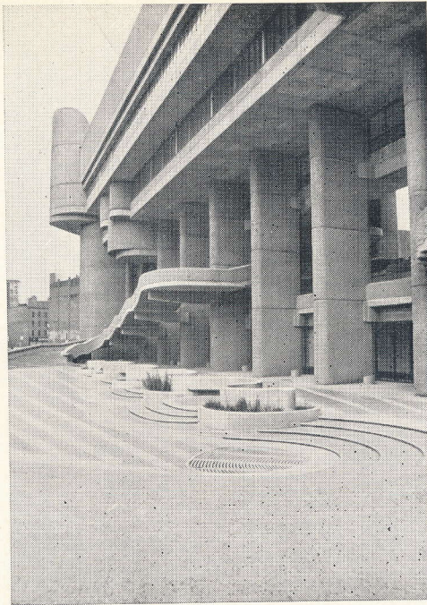
Бостон. Здание административных служб штата. Вид со стороны улицы.
