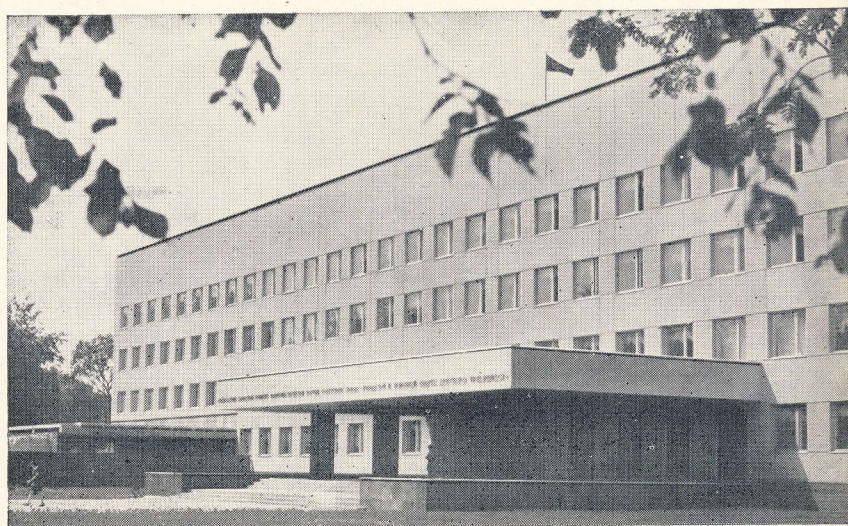
Подольск. Административное здание. Архитекторы Б. Луньков, Л. Скорб. Общий вид
