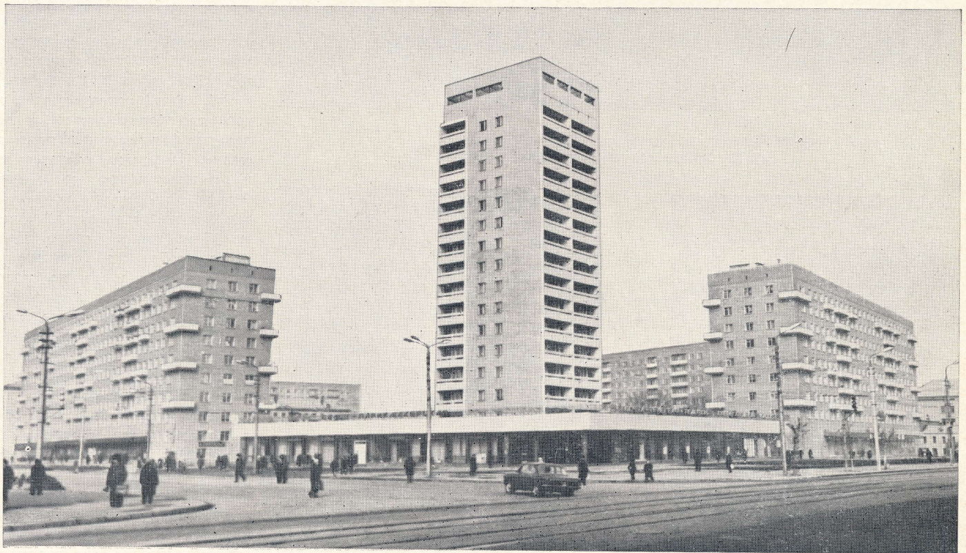
Тула. 16-этажный жилой дом на Красноармейском проспекте, возведенный методом скользящей опалубки. ЦНИИЭПжилища.
