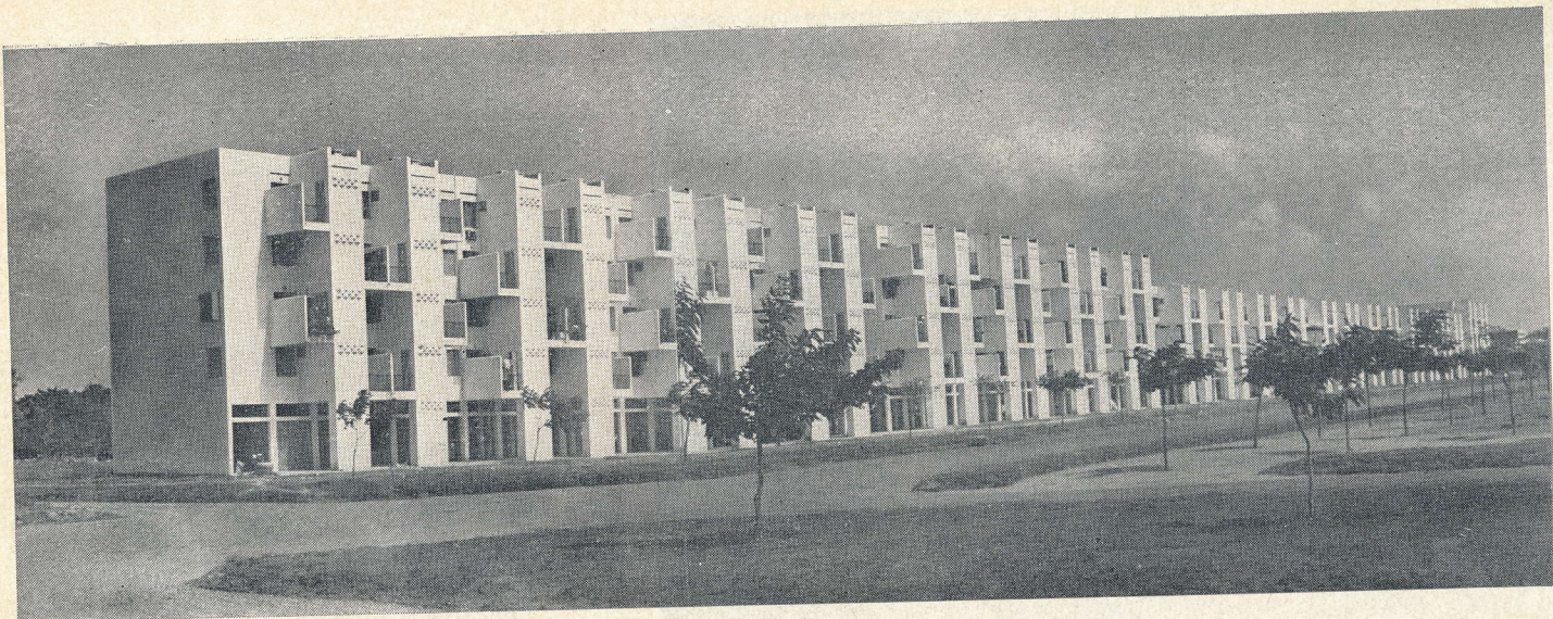
Жилой комплекс в Пном-Пене
