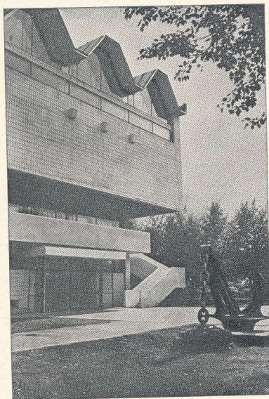
Фрагмент главного фасада
