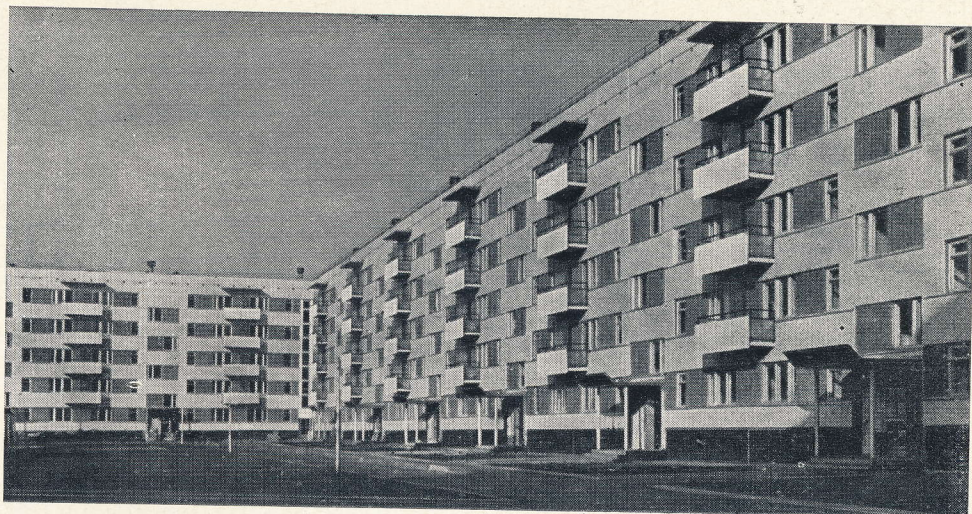
Пятиэтажные жилые дома из блок-секций серии 1-468 БНЧ
