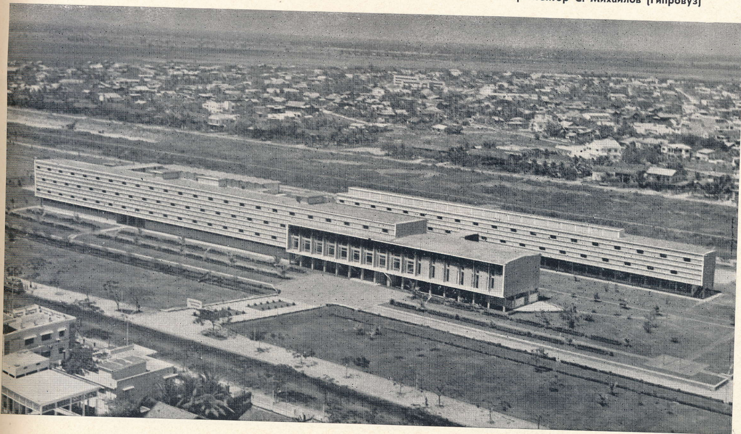
Комплекс Высшего технического института кхмеро-советской дружбы в Пном-Пене. Архитектор С. Михайлов (Гипровуз)
