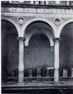
годы, Л. Лаурана. Капители на стене лишь подчеркивают места опоры сводов и связывают стену с аркадой портика
