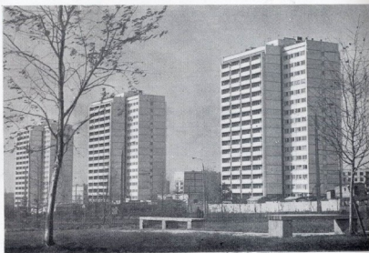
Москва. Жилые дома на проспекте Вернадского
