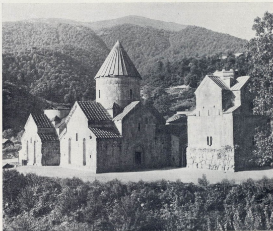
Монастырь Гошаванк. Вид с северо-востока
