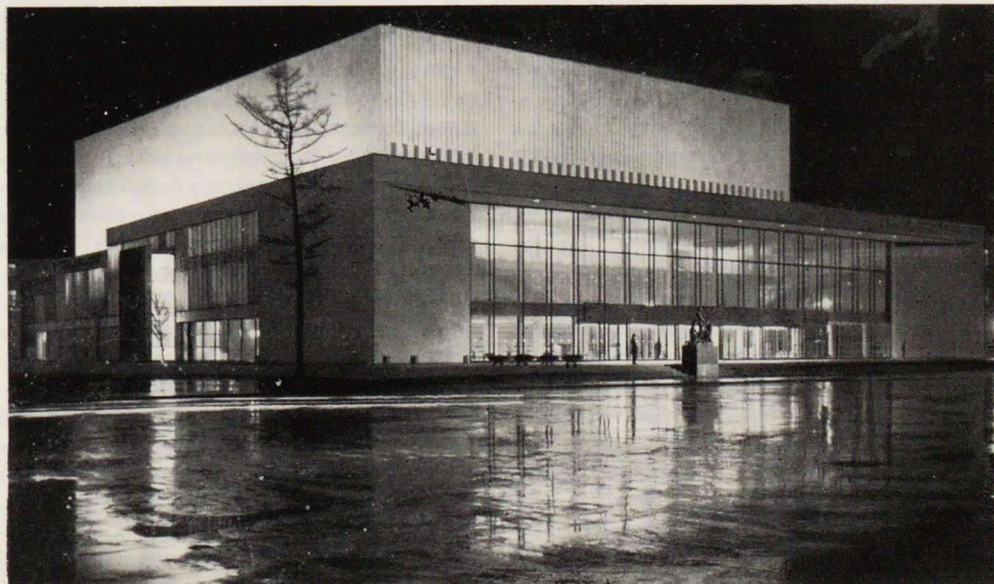
Ленинград. Большой концертный зал «Октябрьский». Архитекторы В. Каменский, Ж. Вержбицкий, Г. Вланин, А. Жук, инженер Максимов
