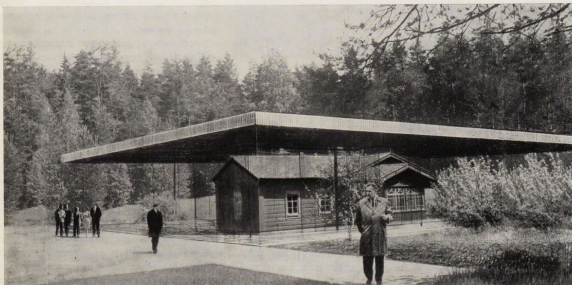
Стеклянный павильон в Ильичево. Коллектив архитекторов под руководством Е. Полторацкого
