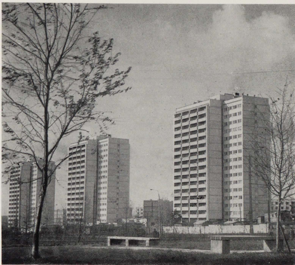
Односекционные 16-этажные каркасно-панельные дома на проспекте Вернадского
