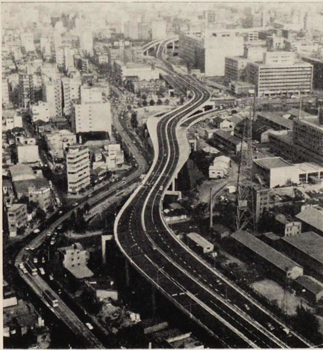
Характерный прием прокладки скоростной дороги с использованием русла реки
