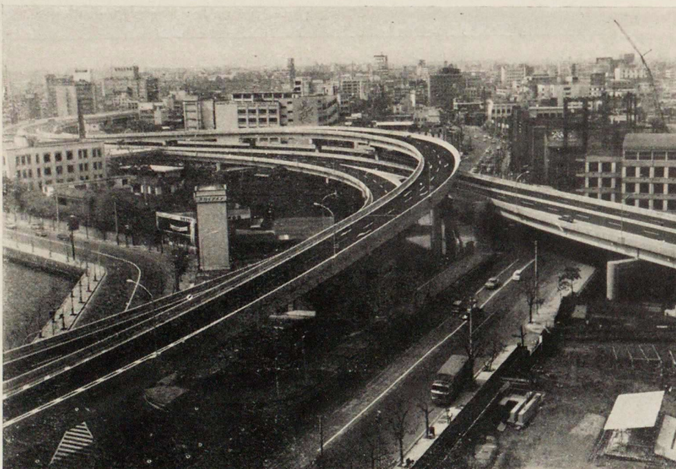
Решение дугообразного примыкания в сложных городских условиях при прохождении скоростной дороги над уличной сетью города
