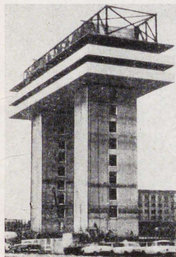
Рис. 3. Строительство здания торгового центра в Сан-Педро [Калифорния]
