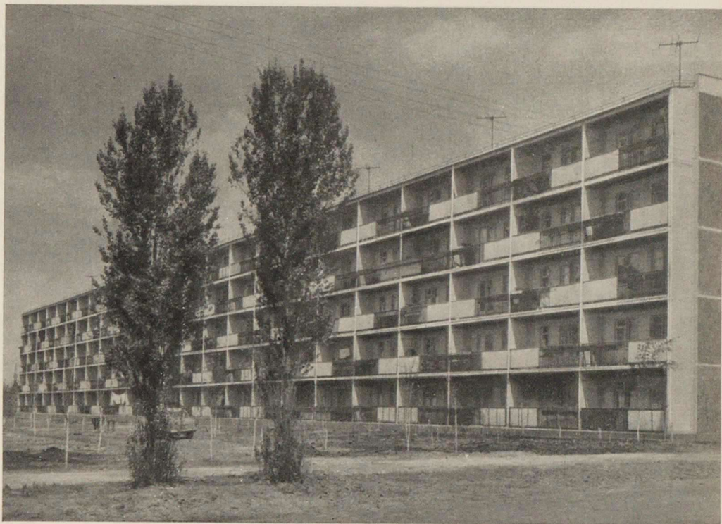
КИЕВ. ДАРНИЦА. ЭКСПЕРИМЕНТАЛЬНЫЙ ЖИЛОЙ ДОМ С ПОПЕРЕЧНЫМИ НЕСУЩИМИ СТЕНАМИ
