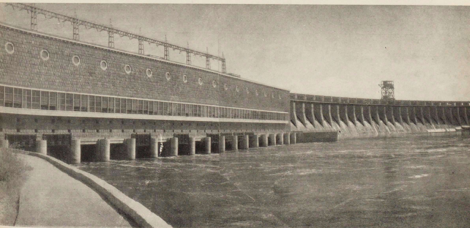
Силовая станция и плотина Днепрогэса в Запорожье. 1927—1932 гг. Архитекторы В. Веснин, Н. Колли, Г. Орлов, С. Андреевский
