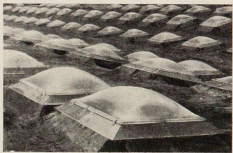
Рис. 6. Общий вид светопрозрачных куполов из органического стекла, установленных на кровле производственного корпуса Полтавского завода алмазных инструментов
