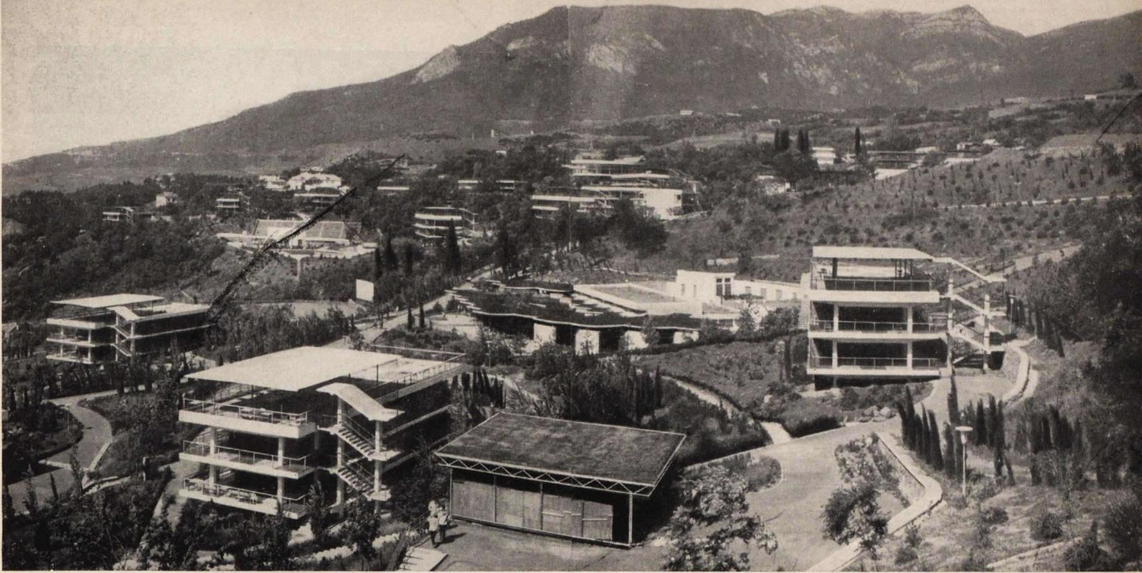
Артек. Панорама пионерского лагеря «Прибрежный». Все здания смонтированы из унифицированных вариантных железобетонных конструкций
