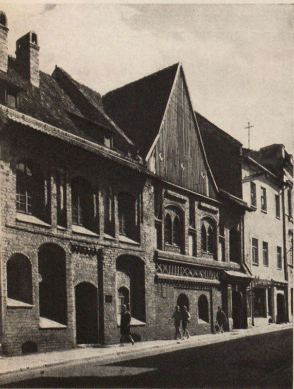
Жилой дом XVI в. по улице Горького, 12. Раскрытие и фрагментарная реставрация
