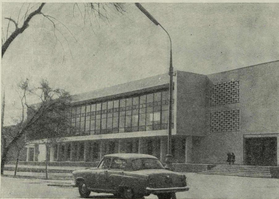
отечественного производства начинают применять и наши архитекторы. В качестве примера можно привести здание Госбанка в Ашхабаде, где из теплопоглощающего стекла выполнен витраж на главном фасаде (рис. 2).
