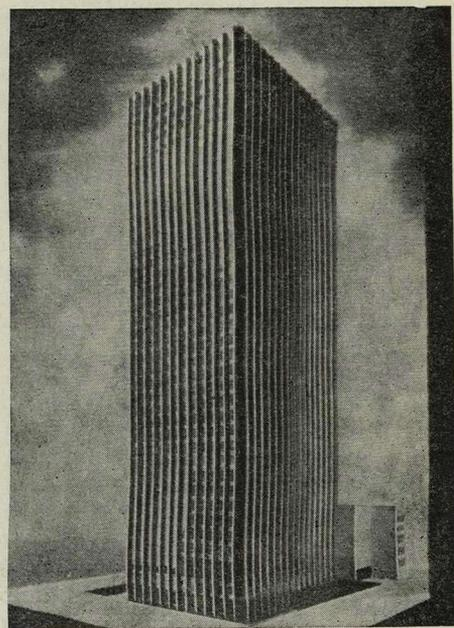
Рис. 4. Проект 38-этажного здания с несущими наружными стенами и свободным планом, построенного в Нью-Йорке
