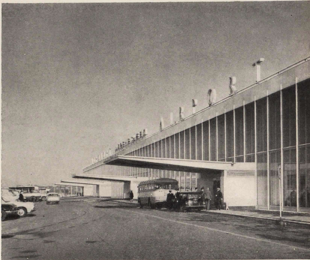
Шереметьево. Центральный фасад
