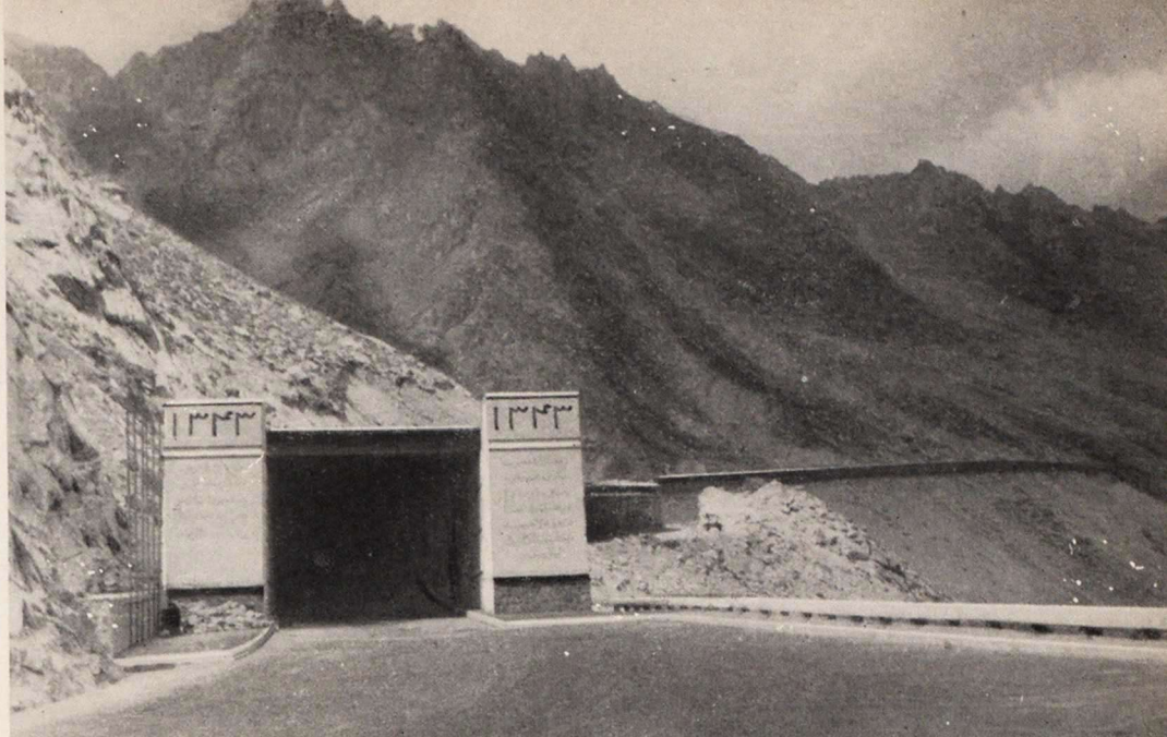
Южный портал галереи и тоннеля через Гиндукуш
