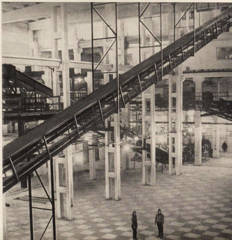
Интерьер производственного корпуса комбината искусственного волокна в Балаково. Промстройпроект
