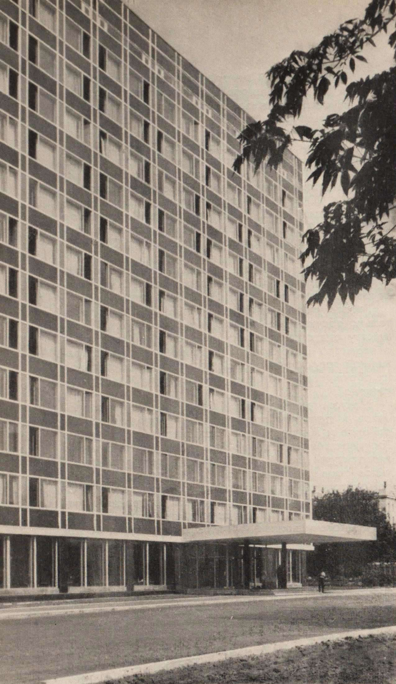
Корпус гостиницы. Фрагмент
