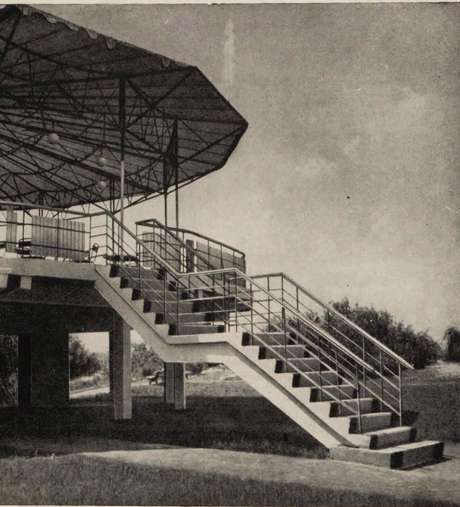
Фрагмент здания столовой
