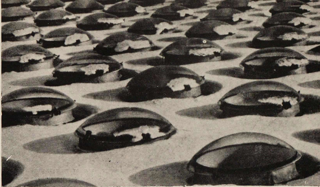
Купола из органического стекла, установленные в покрытии лектория Дворца пионеров в Москве
