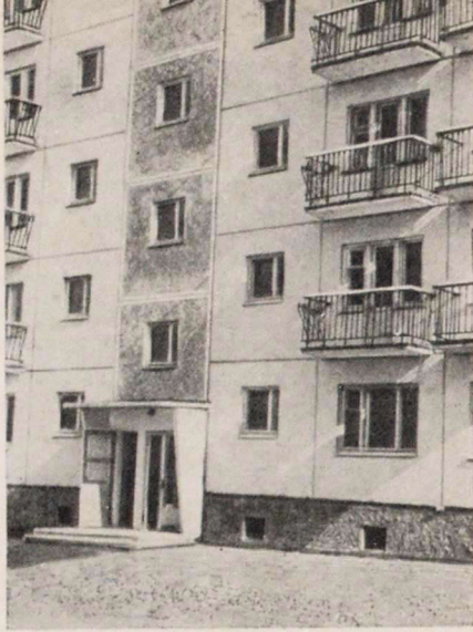
Фрагмент дома с офактуренными панелями, установленными в лестничных клетках
