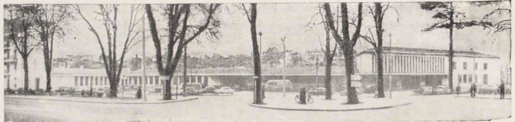
Рис. 5. Общий вид здания вокзала в Пуатье
