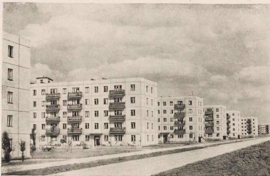
Рис. 6. Харьков. Жилой массив крупнопанельных домов в районе Селекционной станции
