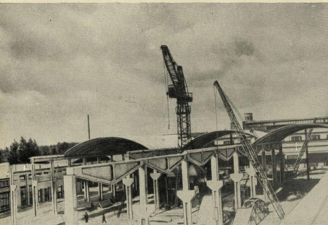
применением сборных железобетонных предварительно напряженных конструкций (ферм, стеновых и кровельных панелей, подкрановых балок и др.). Колонны корпуса приняты применительно к номенклатуре действующих типовых серий.
