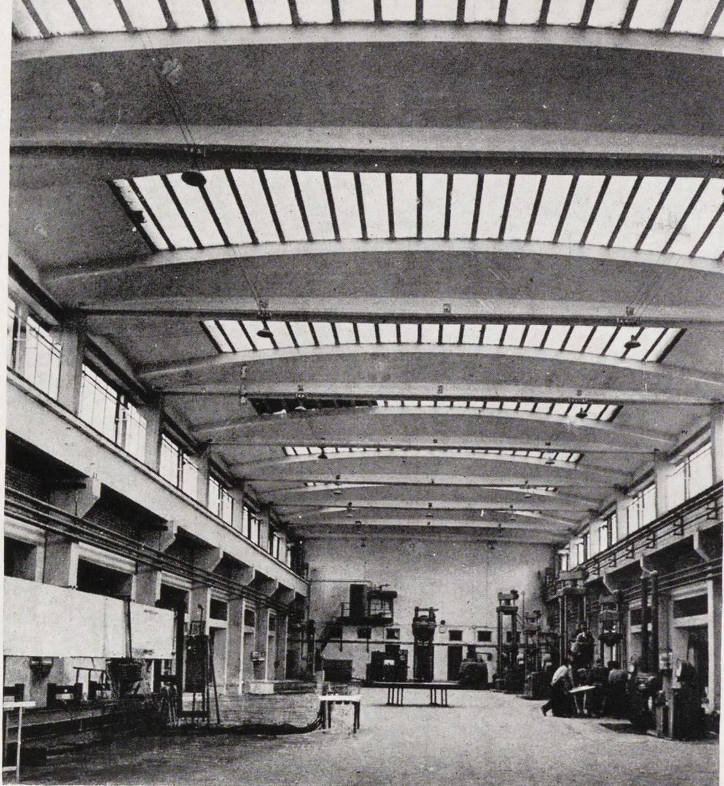
ЛЕНИНГРАД. Здание экспериментальной базы Ленинградского филиала АСИА СССР. Сооружено из сборного железобетона
