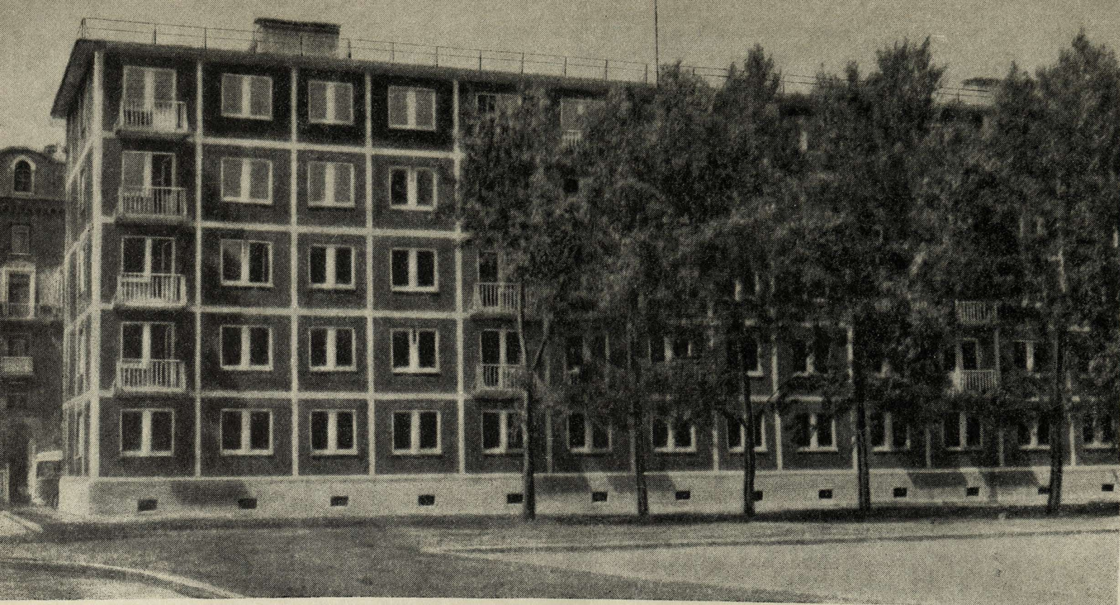
Крупнопанельный жилой дом на 2-й улице Октябрьского Поля в Москве. Архитектор В. Асс
