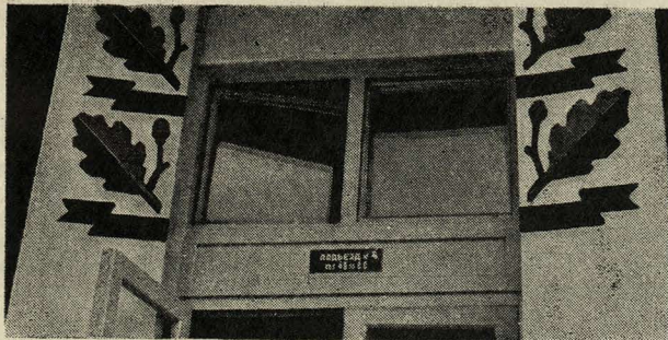
Деталь портала жилого дома на 2-й улице Октябрьского Поля. Орнамент из цветного бетона выполнен на заводе
