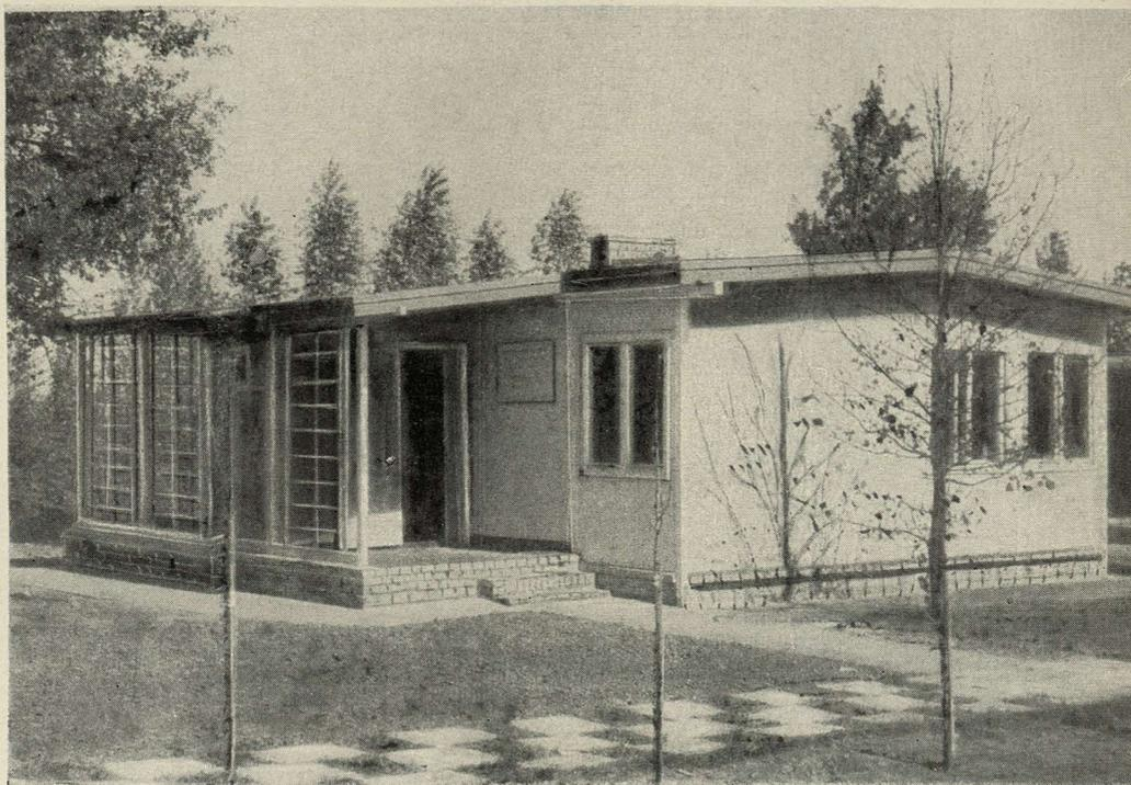
Перегородки выполнены из сухой штукатурки по реечному каркасу. Полы запроектированы из полихлорвиниловых плит. Кровля — рулонная, совмещенная, что создает наклонный потолок во всех помещениях. Высота от пола до потолка более низкой части помещений 2,35 м и более высокой — 2,65 м. Простота объемно-пространственно-
