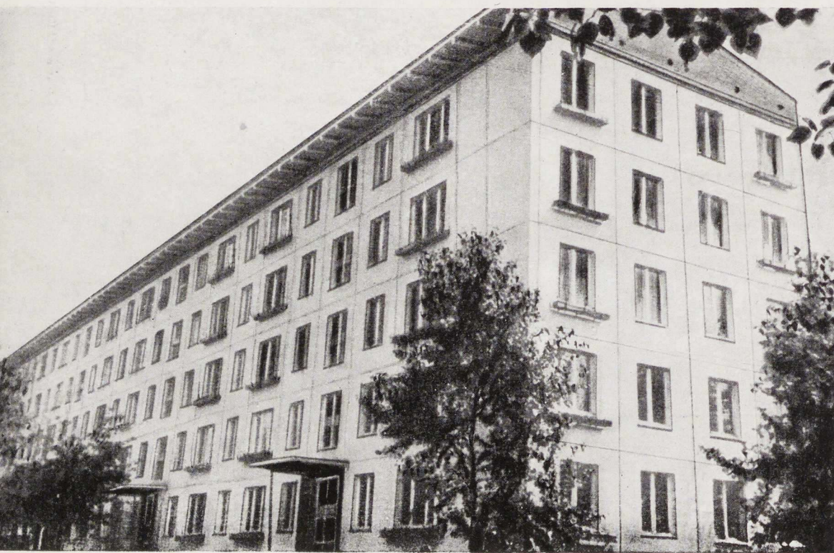
Опытный двухэтажный кирпичнопанельный жилой дом из панелей размером на комнату
