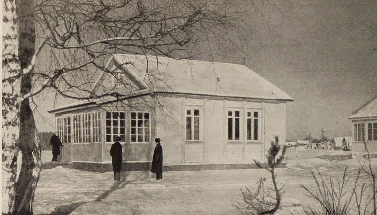
Одноквартирный трехкомнатный жилой дом из сборных ребристых железобетонных стеновых панелей. Общий вид, узел карниза и план
