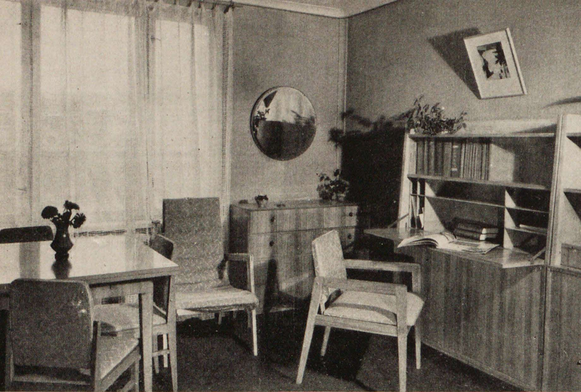
Рис. 5. Общий вид квартиры в экспериментальном объемном блоке
