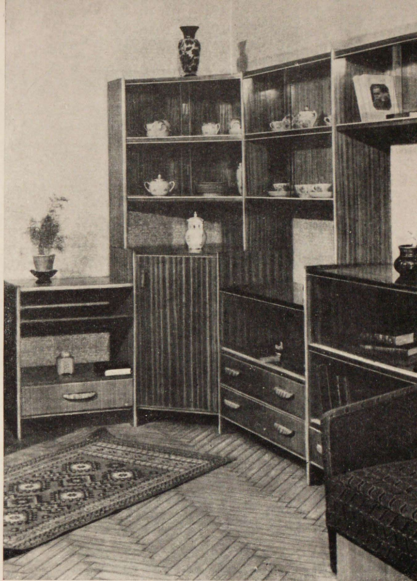
Универсальная разборная мебель, разработанная Центральным проектно-конструкторским бюро Мосгорсовнархоза (поощрительная премия) состоит из плоских щитков унифицированных размеров, соединяемых специальными винтами. Размер секций по фасаду (в свету) — 860 мм; толщина стенок — 20 мм; высота боковых щитков первого яруса — 866 мм, общая высота в представленном варианте — 1728 мм. Боковые стенки нижнего яруса устанавливаются непосредственно на пол
