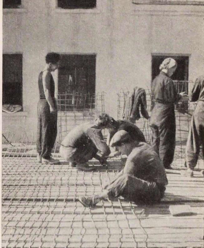
Студенты на строительстве Тайшетского железнодорожного узла. За сборкой арматуры для железобетонного резервуара
