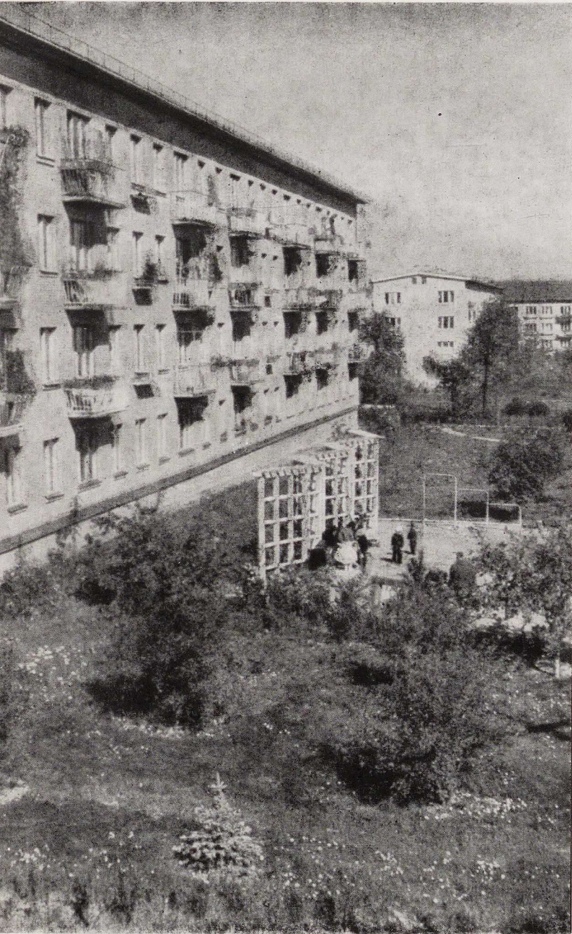
Благоустройство четвертого двора
