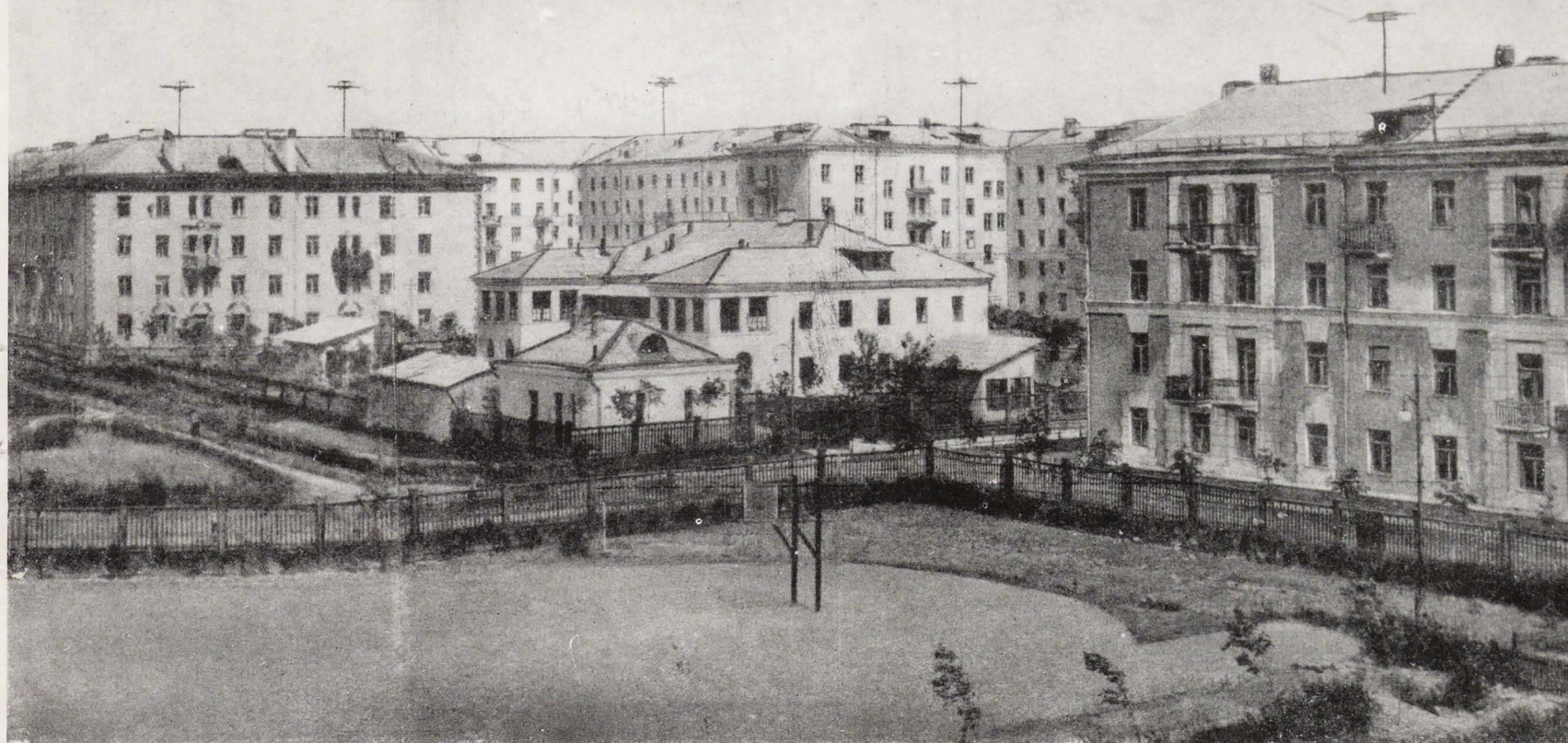
Квартал № 5 в г. Электростали
