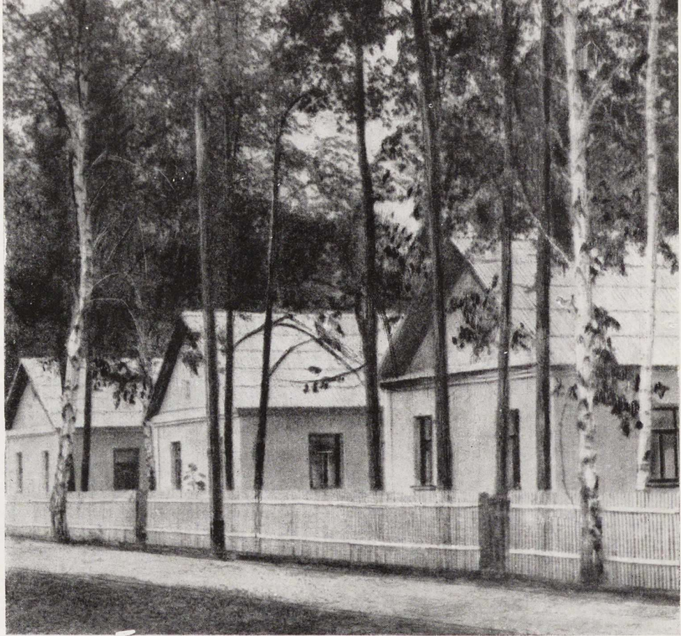
Индивидуальное строительство в г. Ступино
