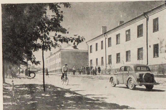
Новые жилые дома на улице Труда, построенные по методу горьковчан силами рабочих и служащих
