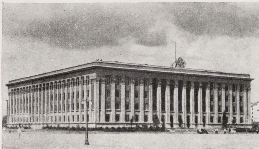
Административное здание на центральной площади. Архитектор Ли хен, инженер О ен хи
