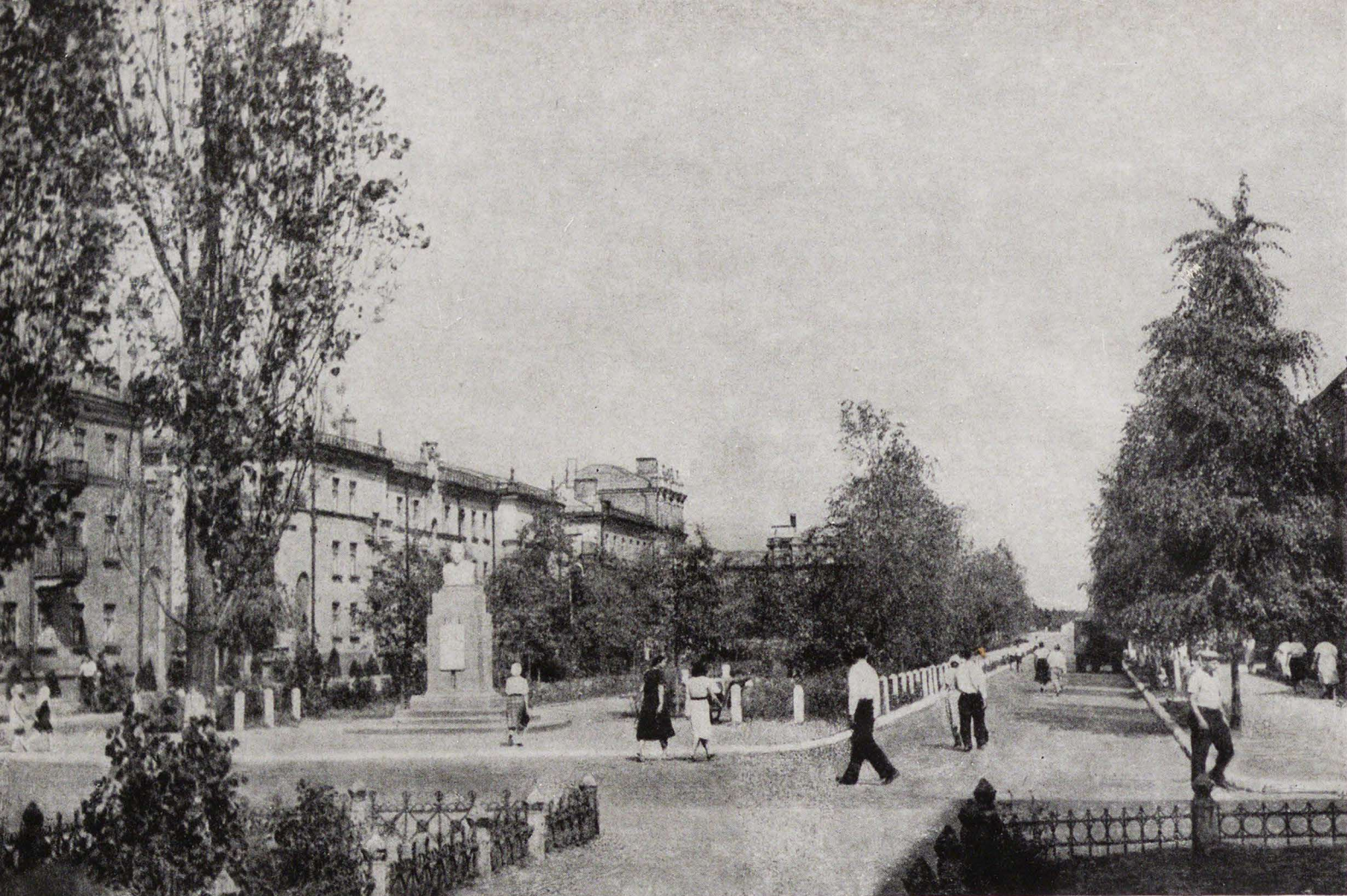
Северодонецк. Строительство жилых домов на улице Ленина
