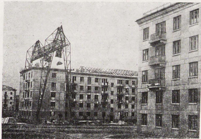
Ворошиловск. Строительство домов из крупных блоков
