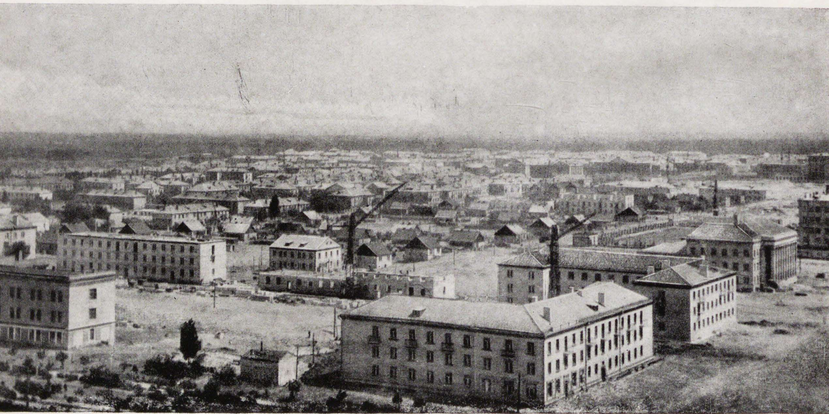
Северодонецк. Строительство новых кварталов
