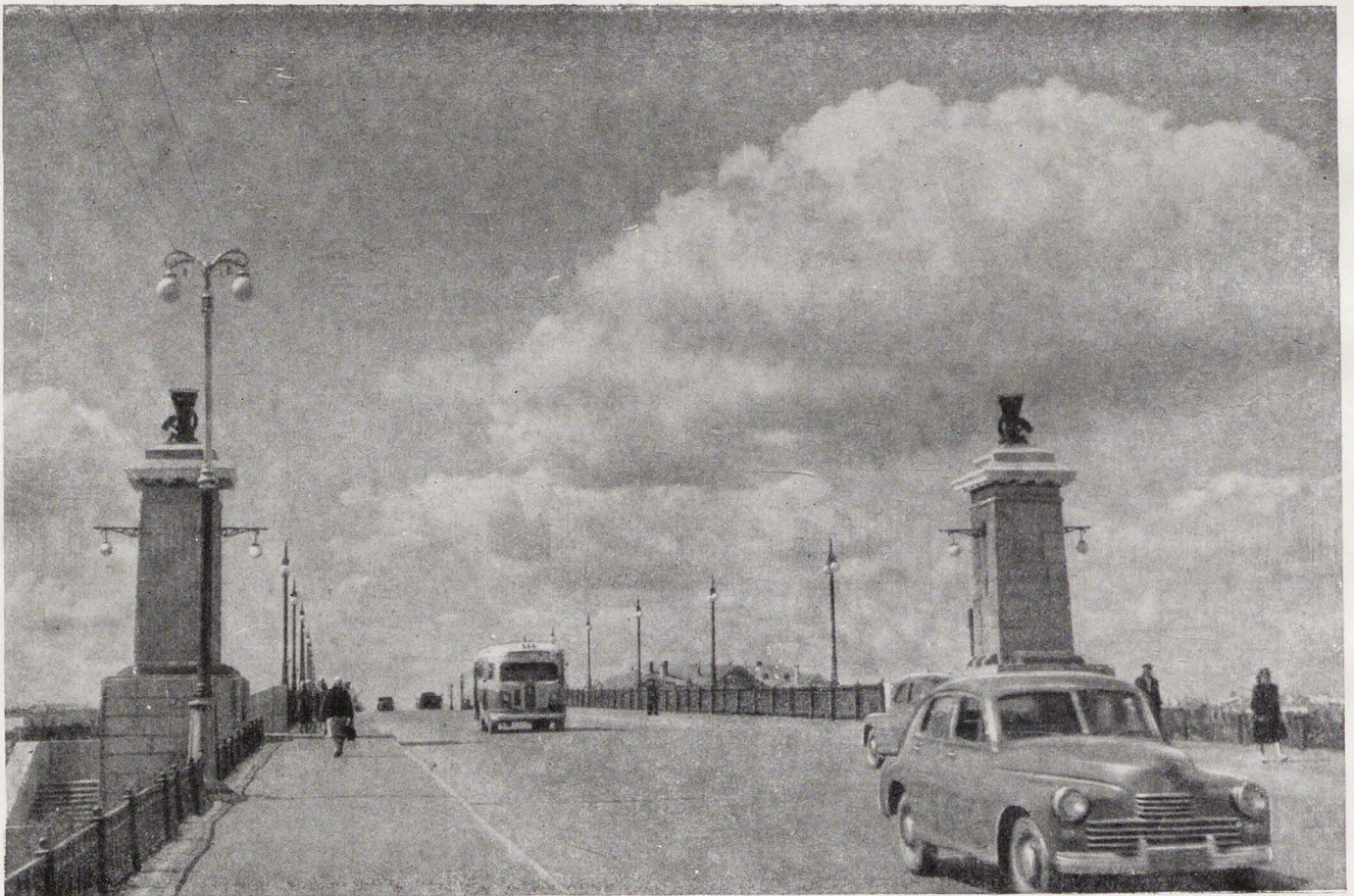
Новый мост через Волхов
