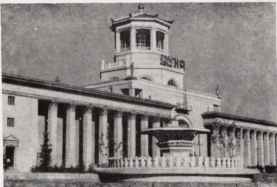
Центральный железнодорожный вокзал. Архитекторы Фан и Ган
