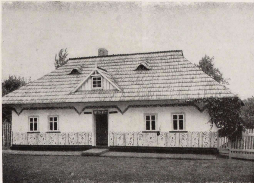
Село Острица Черновицкой области. Каркасный дом
