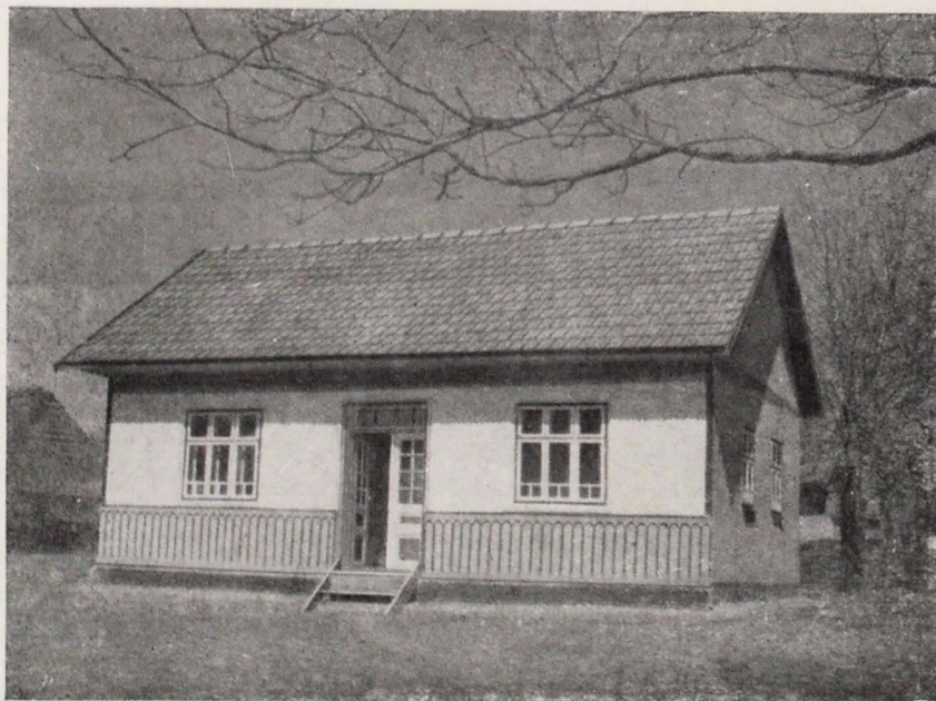
Село Острица Черновицкой области. Каркасный дом
