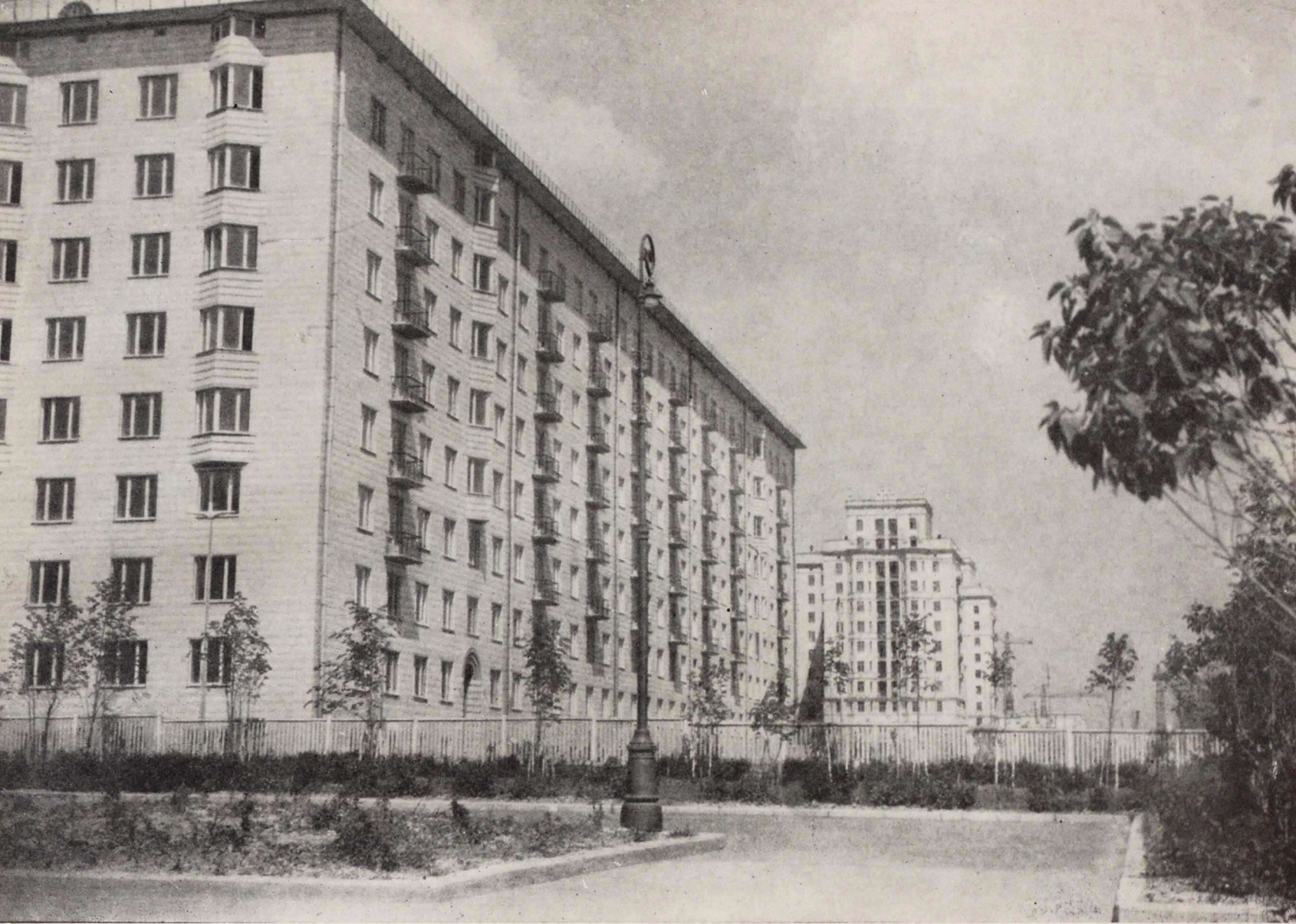
Жилой дом 10-б в 13-м квартале Юго-Западного района Москвы
