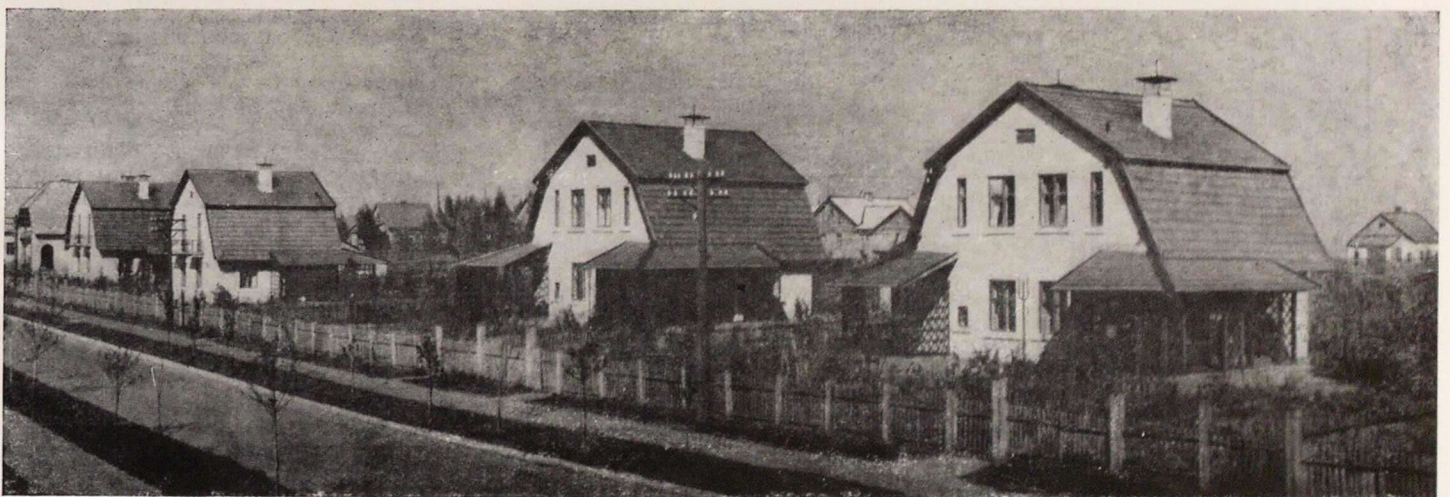
Село Тарасовка Киевской области. Новые жилые дома рабочих газопровода
