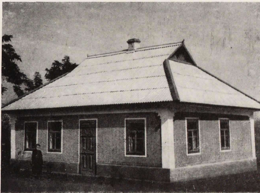
Село Ольгополь Винницкой области. Каркасный дом. Стены глиновальковые
