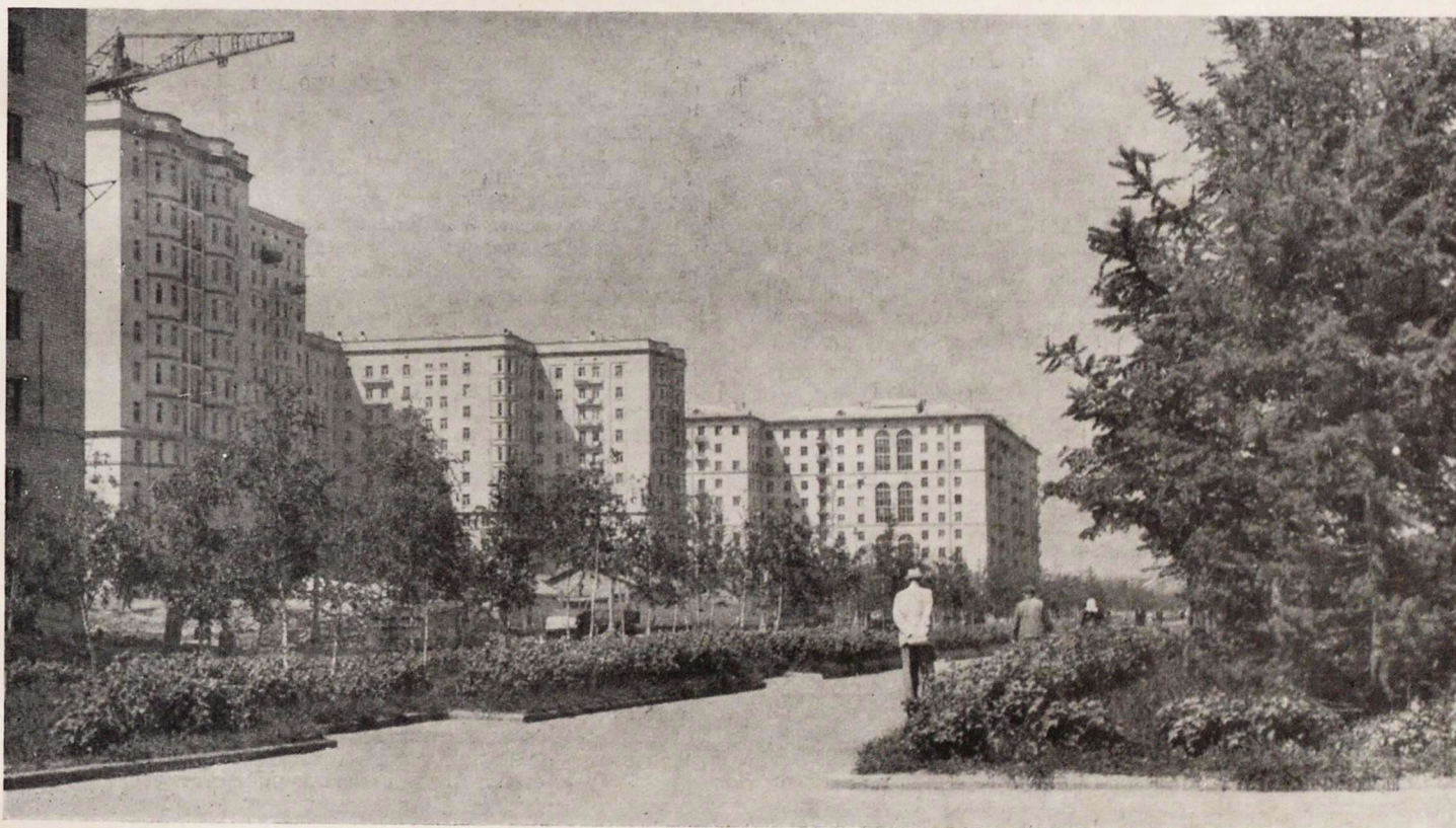
Второй квартал. Вид со стороны Университетского проспекта. Строительство 1954—1956 годов
