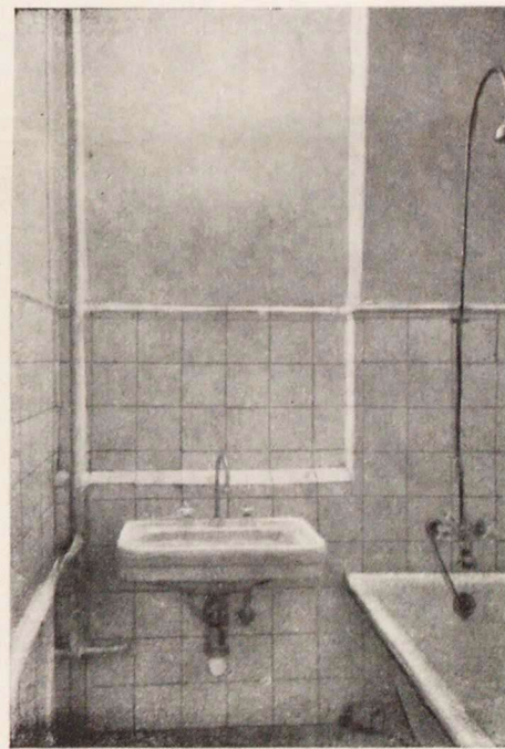
Ванная комната. Стеновая панель облицована метлахской плиткой
