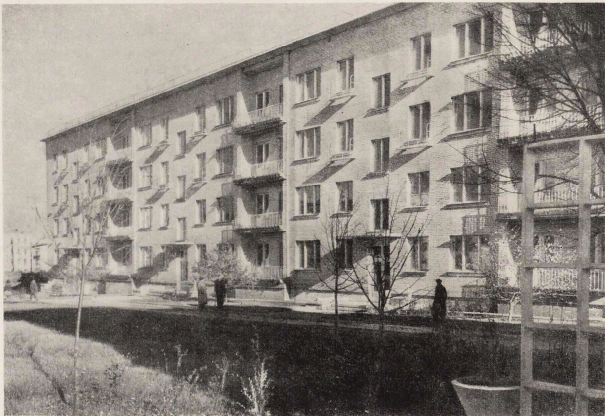
Жилой дом № 12. Вид со стороны двора
