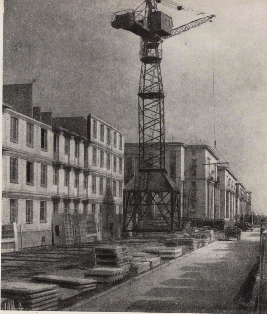
Монтаж крупнопанельного дома в 123-м квартале на Ивановской улице в Ленинграде (район Щемиловки)
