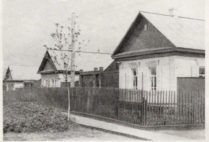
Индивидуальные шлаколитые одноквартирные дома в Сталинском районе Челябинска. Стены отлиты из шлакобетона в передвижной деревянной опалубке
