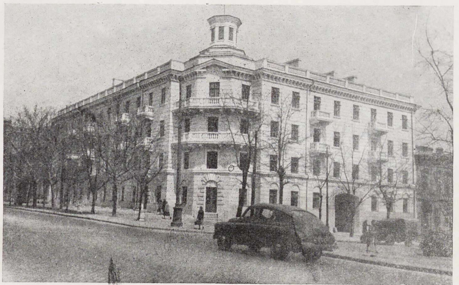
Одесса. Новый дом на углу Пушкинской и Жуковской улиц
