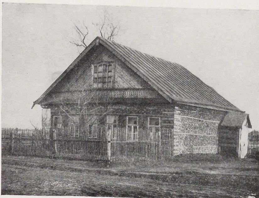
изоляции от сырости нет. Грунт под избы глинистый. Нижние ряды поленьев стены, не изолированные от влаги и засыпанные снаружи землей, подгнили, отчего боковые стены, будучи нагруженными (от перекрытий и стропил), дали осадку, значительно большую, чем торцовые.
