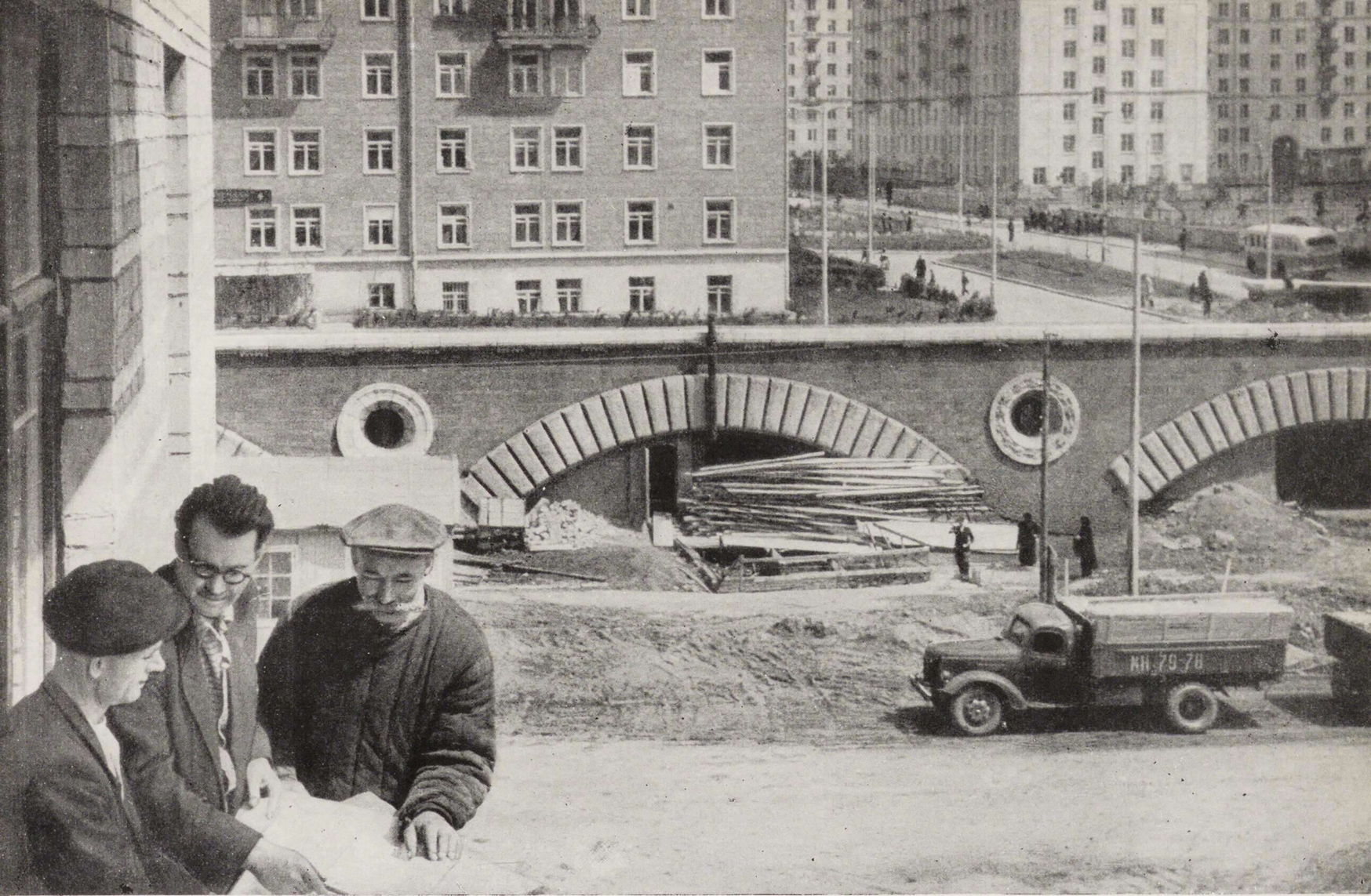
На строительстве 45-го корпуса в Юго-западном районе Москвы. Архитектор И. А. Катков (в центре) дает указания по ходу строительства работ старшему производителю работ М. Е. Бойкачеву (слева) и бригадир В. П. Инкину. Фото Ольги Игнатович
