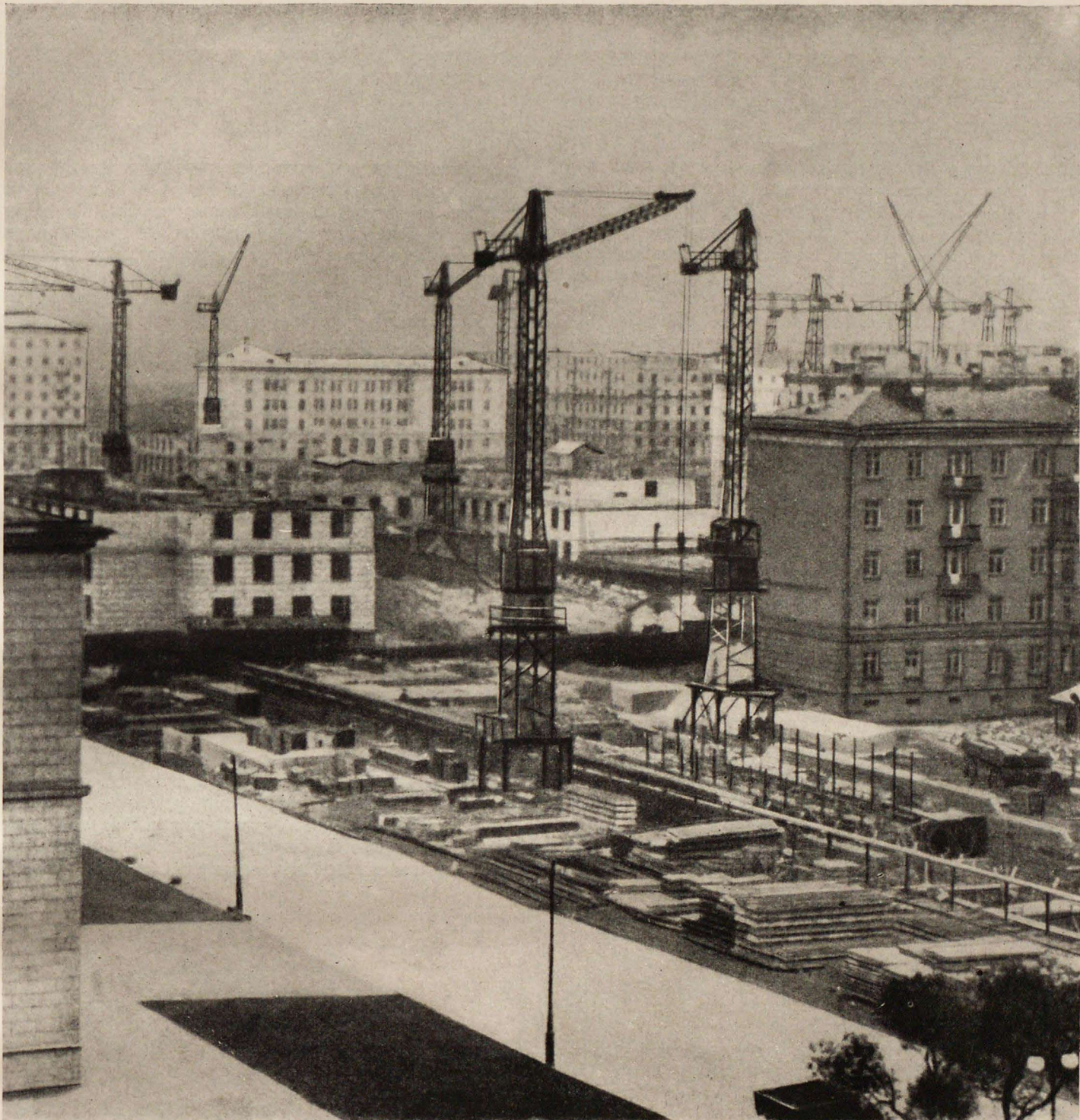
Ленинград. Строительство домов из крупных блоков в 44-м квартале Московского проспекта
