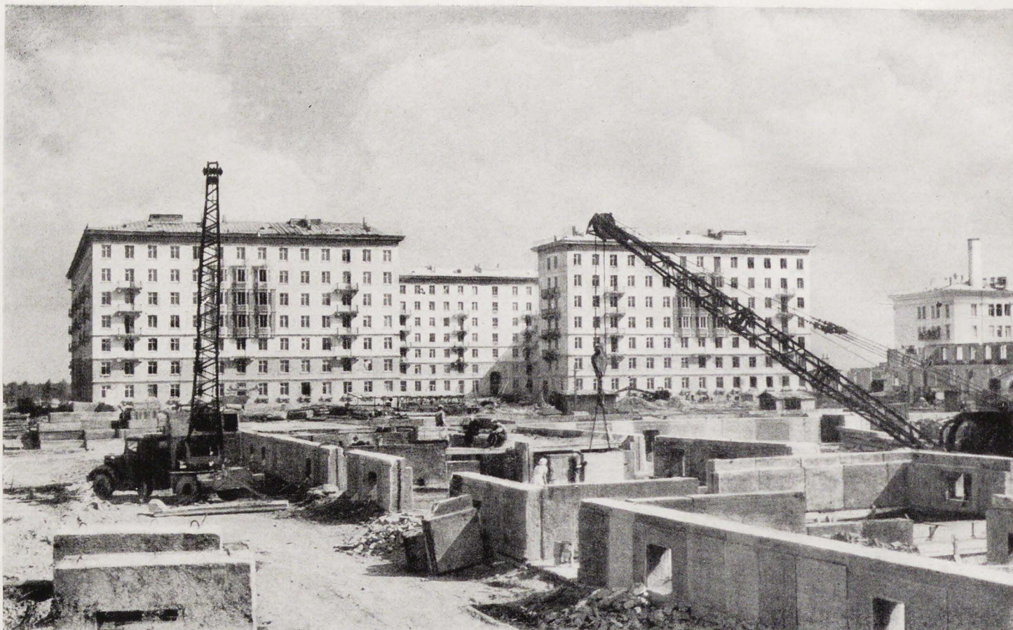
Строительство крупноблочных домов в квартале 44 на Московском проспекте
