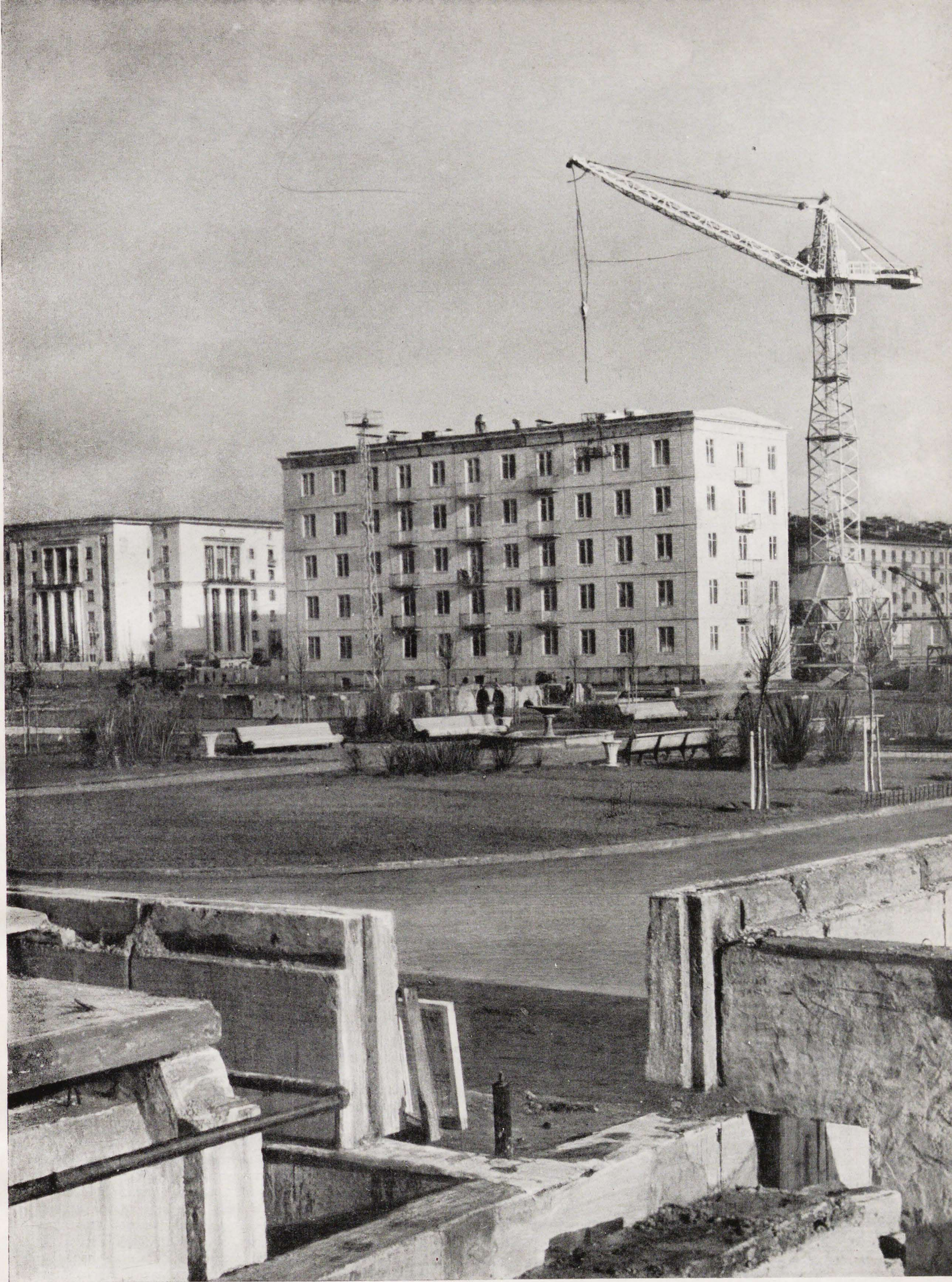
Строительство крупнопанельного дома в квартале 122 на Шемиловке
