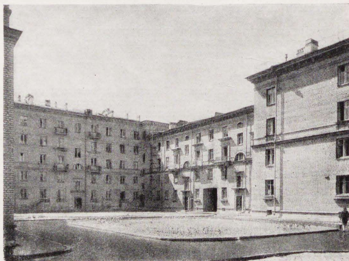
Двор в квартале на улице Савушкина. Пример переуплотненной застройки. 1950—1956 гг.
