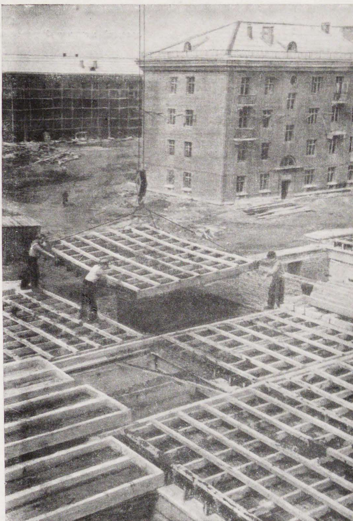
Ангарск. На строительстве 48-квартирного дома. Укладка перекрытия второго этажа
