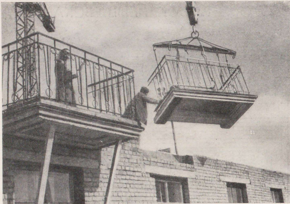
Монтаж балкона на строительстве типовых жилых домов (серия КБ) в 41 квартале Ново-Куйбышевска
