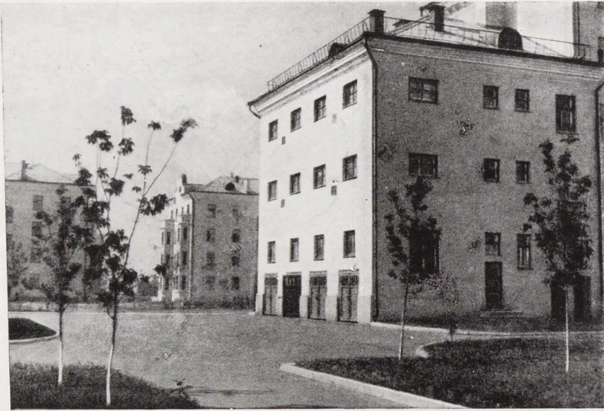
Хозяйственный блок в квартале 16
