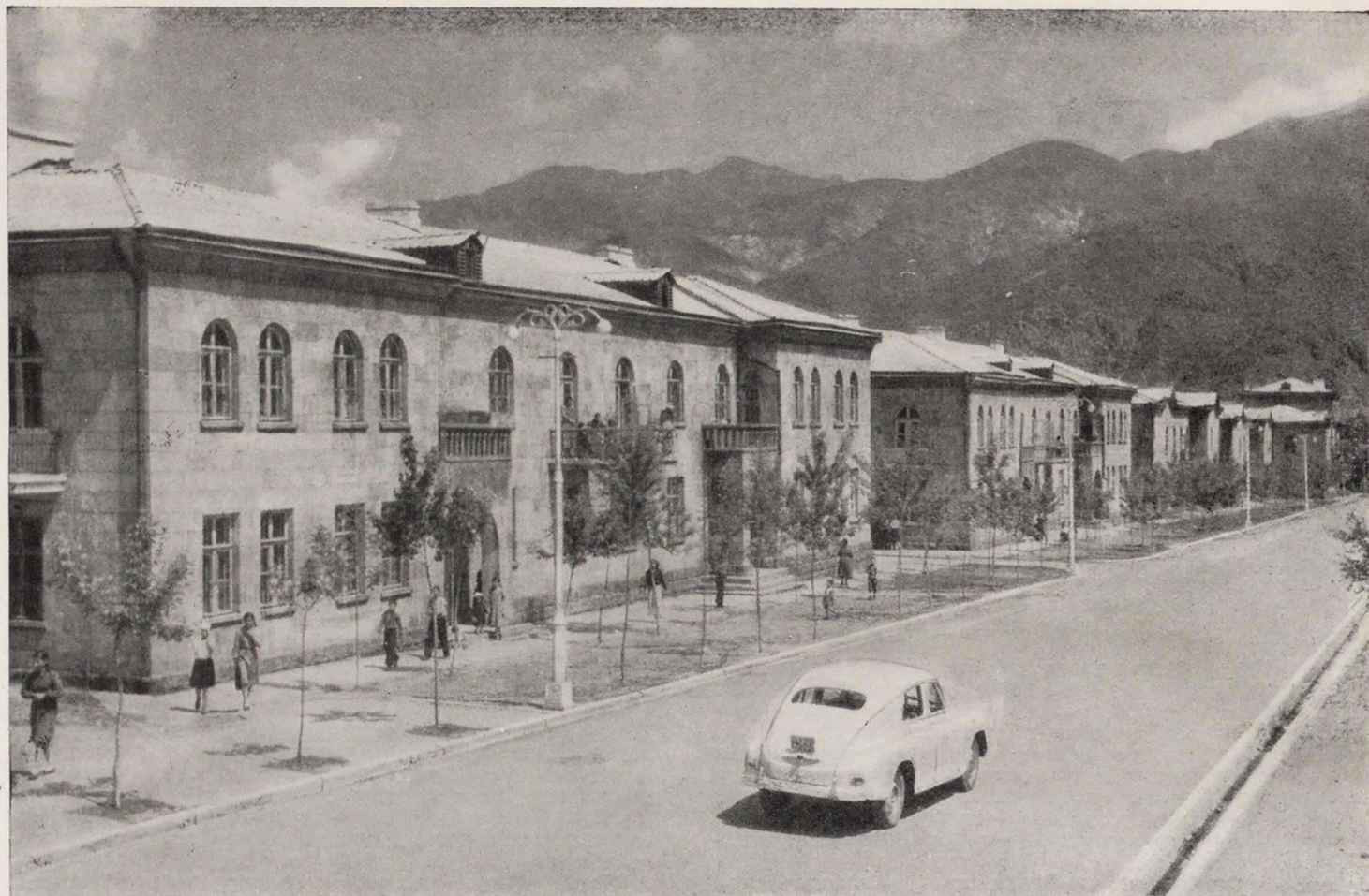
Кировакан. Жилые дома рабочих химического комбината
