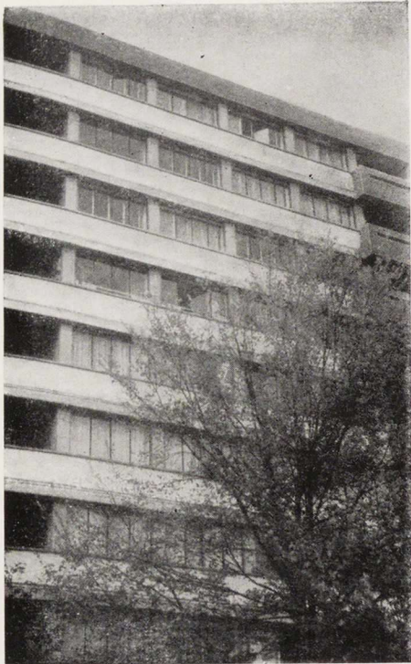
Общий вид современного дома. Каркасный дом с горизонтальными поясами, офактуренными разноцветной кромкой
