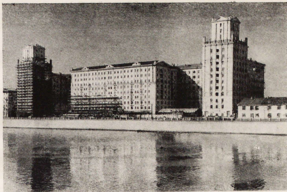
Строительство жилого дома на Бережковской набережной в Москве. Архитекторы И. Кастель и Т. Заикин. Пример неоправданного строительства башен
