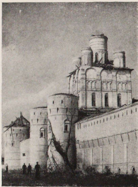
Ростовский кремль. Крепостная стена XVII в. и церковь Иоанна Богослова 1683 г. после разрушения
