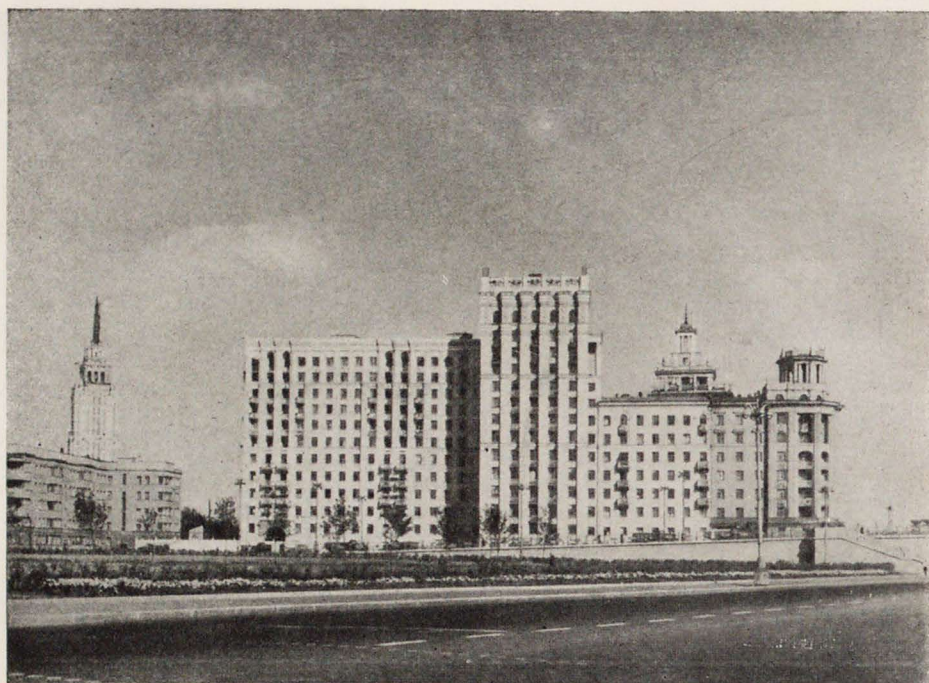
Жилой дом на Б. Дорогомиловской улице в Москве. Архитекторы С. Ляшенко, В. Калафатов и Е. Демченко. Пример неоправданного «обогащения» силуэта застройки
